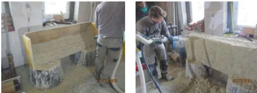
Figura 6.4 - Realizzazione del provino in cantiere
