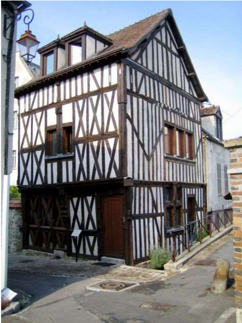
Figura 4.6 - Maison de la Turquie, a Nogent sulla Senna; 1986, primo rinnovamento edilizio con conglomerato alleggerito con la canapa
