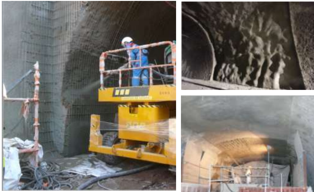
Figura 5.11 - Applicazioni calcestruzzo proiettato; Asquapro
