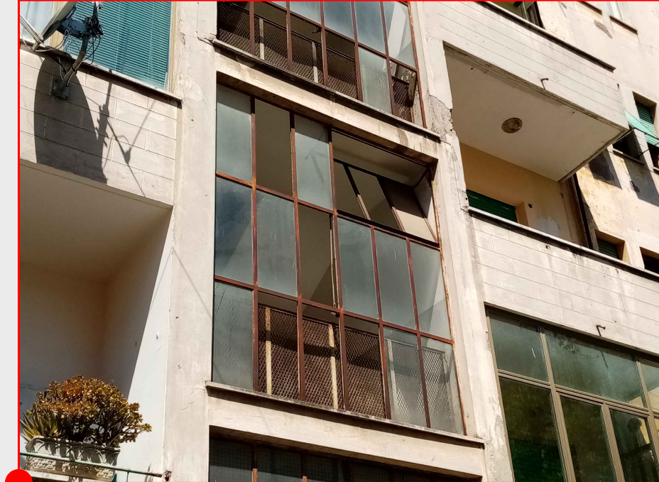
Vetrata del corpo scala: oltre alla corrosione del ferro, è da segnalare la perdita di molte lastre di vetro da cui conseguono grandi dispersioni termiche che vanno a scapito dell'intero edificio (le dispersioni sarebbero comunque notevoli anche se le lastre fossero tutte presenti perché si tratta di vetri singoli con spessori esigui).
