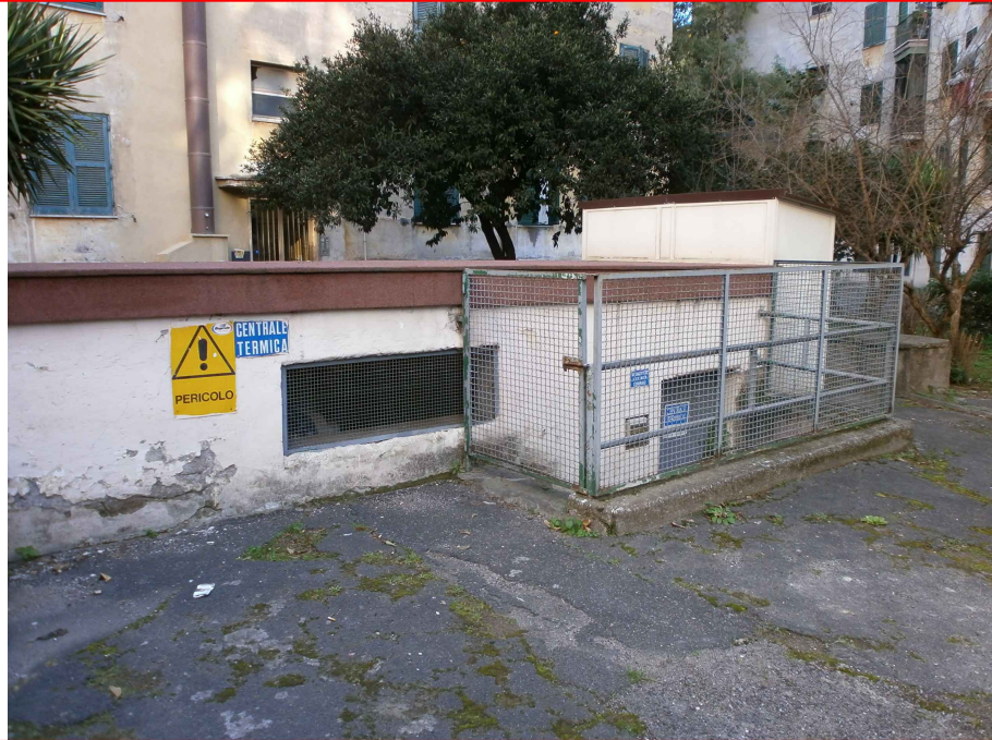
Impianto di riscaldamento non efficiente: è una causa importante degli sprechi energetici. Nella foto è visibile la centrale termica che serve l'intero lotto 57, nella gran parte dei condomini non è presente un sistema di termoregolazione e contabilizzazione del calore individuale. Questa situazione porta, per le vecchie centrali termiche, ad un rendimento globale medio stagionale compreso tra il 55% ed il 60% (contro l'80-90% di quelle attuali)¹.
