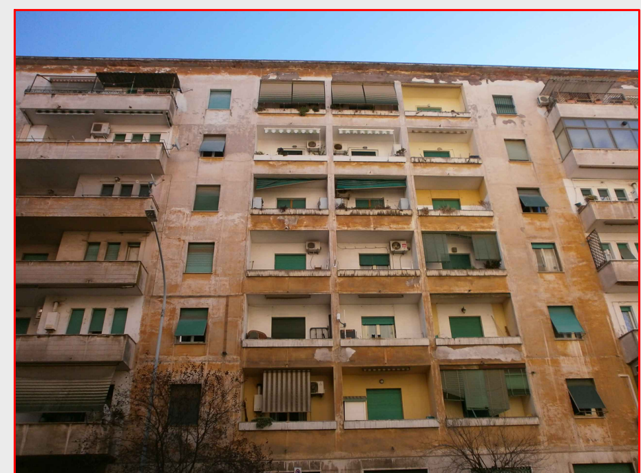
Alcuni difetti di costruzione, la mancanza di manutenzione e le azioni degli agenti atmosferici hanno portato all'ammaloramento delle finiture. Per la pittura e per l'intonaco, i principali fenomeni di deterioramento sono: il dilavamento, l'alterazione cromatica, l'effoliazione, il distacco e la perdita. Per quanto riguarda le lastre di travertino, sono presenti fenomeni di fratturazione (foto sul lato destro), incrostazione, perdita e macchie da vernici causate dalle scritte vandaliche (che non comprendono l'opera autorizzata di Street Art degli artisti Sten e Lex, presente sul fronte sud). Le cavillature strutturali, visibili nella foto al centro, dipendono dalle diverse conduttività termiche dei materiali della struttura in calcestruzzo armato e di quelli del tamponamento murario. Al variare della temperatura si modificano le dimensioni degli elementi eterogenei, creando ovviamente diversità di dilatazioni che l'intonaco non sempre è in grado di contenere, rompendosi.
