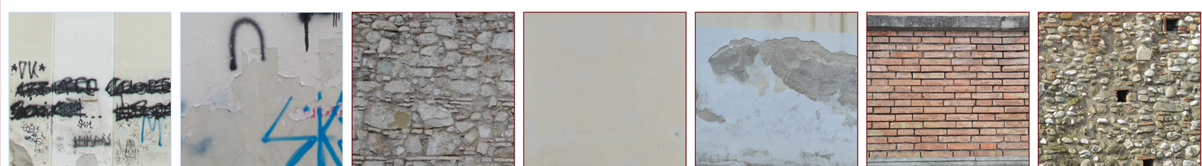
1. Prospetto Ovest muratura mista in blocchi di pietra e laterizio intonacata, 2. Prospetto Nord-Ovest muratura mista in blocchi di pietra e laterizio intonacata, 3. Prospetto Est muratura mista in blocchi di pietra e laterizio a vista nella fascia basamentale, 4. Prospetto Est muratura mista in blocchi di pietra e laterizio intonacata nei piani superiori, 5. Prospetto Est muratura mista in blocchi di pietra e laterizio intonacata nella fascia basamentale, 6. Prospetto Est parapetto del terrazzo realizzato nel 1931 con muratura in laterizi, 7. Prospetto Est mura longobarde realizzate in opus incertum
